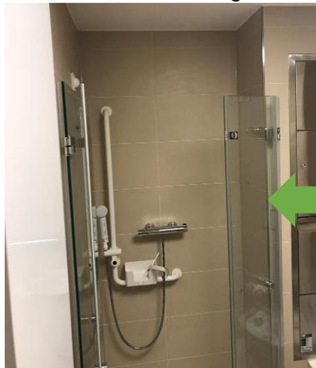
Teilweise wird eine automatische Schlauchentleerung gefordert. Dadurch soll vermieden werden, dass Restwasser im Schlauch verbleibt und der nächste Duschende erst einmal dieses Wasser abbekommt. Allerdings ist der Auslauf an der Armatur, sodass es nur funktioniert, wenn der Duschschlauch nicht – wie im Foto unten – durchhängt:
