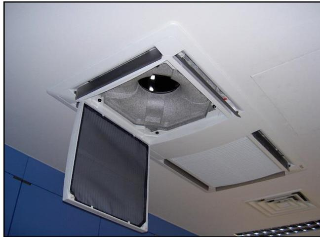
Typisches Sekundär(Umluft)kühlgerät, in die Decke eingebaut.
