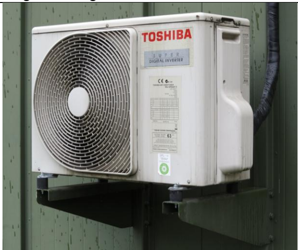
Außengerät einer Split-Anlage (Foto Wikipedia).
