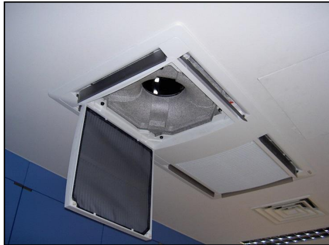
Typisches Sekundär(Umluft)kühlgerät, in die Decke eingebaut.
