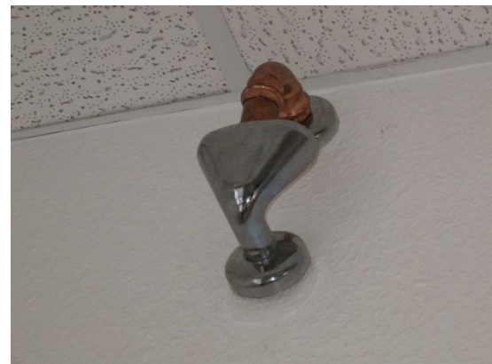
Korrekte Ableitung des Kondenswassers aus einem Sekundär(Umluft)kühlgerät in der Decke.
