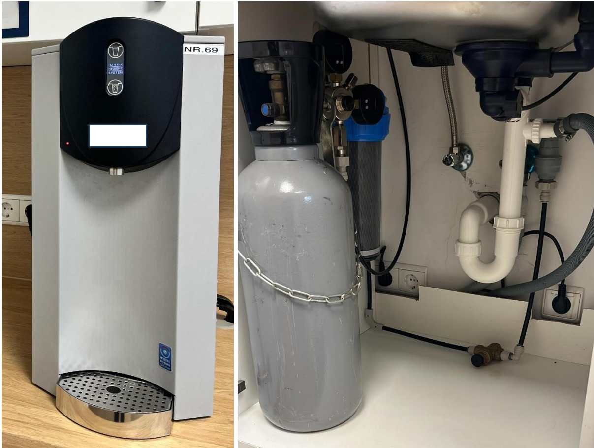
Abbildung 9: Leitungsgebundener Trinkwasserspender sowie zugehörige Technik (bspw. CO 2 – Flasche und Filter). Fotos Meike Rudke
