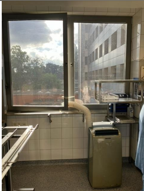
Unsinnige Installation eines Monoblock-Gerätes – über das geöffnete Fenster kommt ständig wieder warme Luft in den Raum.
