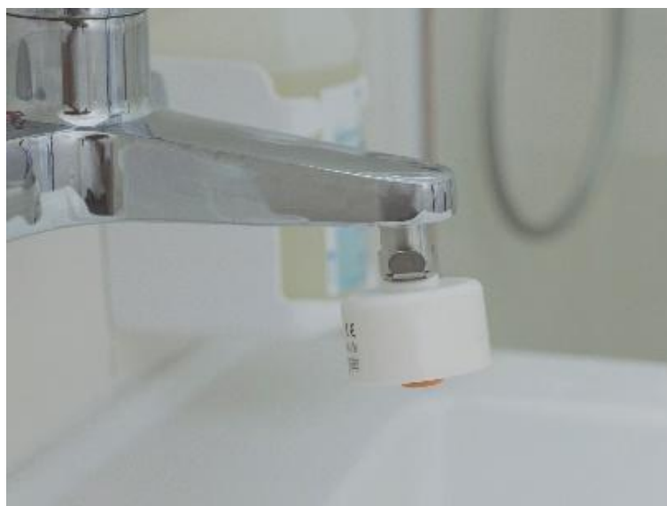
Abbildung 8: Endständiger Wasserfilter an einer Wandeinhebel-Mischarmatur
